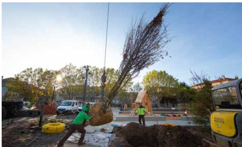
Pour installer les arbres dans les fosses de plantation essaimées partout sur la place, une grue de 60 t est intervenue, avec 3 hommes de pied : deux pour guider manuellement l'arbre, un pour contrôler l'ensemble de la manœuvre.
